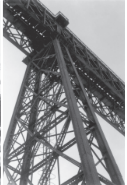
Fig. 3. Puente de Guadahortuna. Pilar de hierro.
