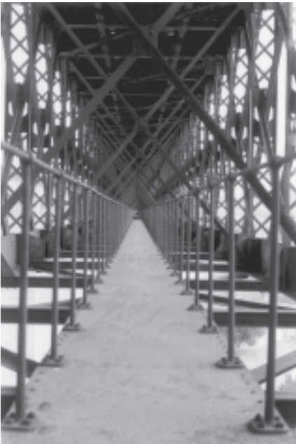
Fig. 2. Puente de Guadahortuna. Pasadizo volado.
