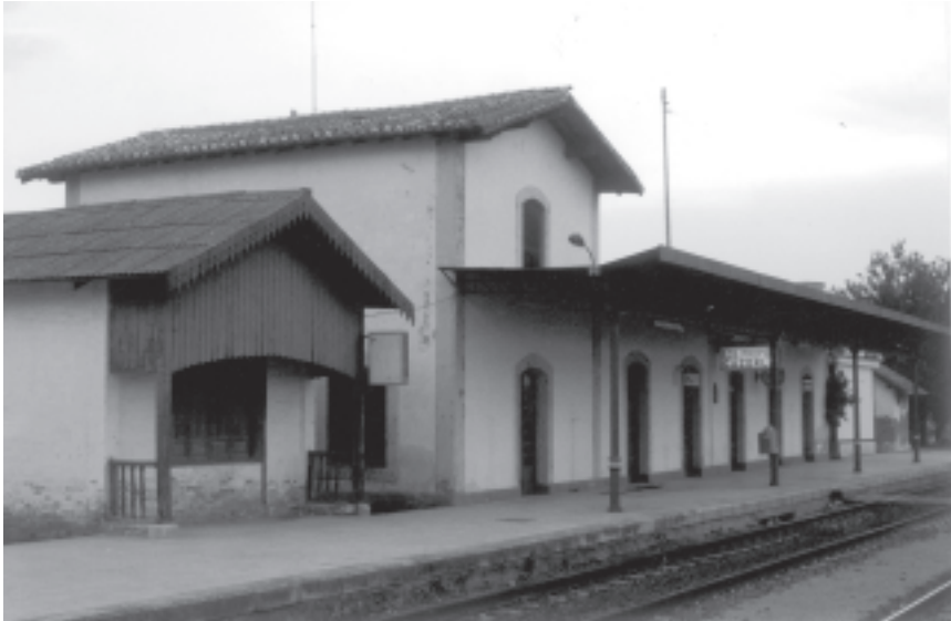
Fig. 7. Estación de Los Propios (Cazorla).
