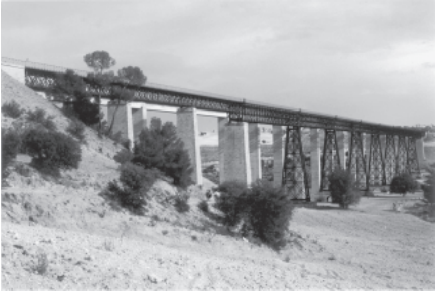
Fig. 1. Puente de Guadahortuna. Vista general.
