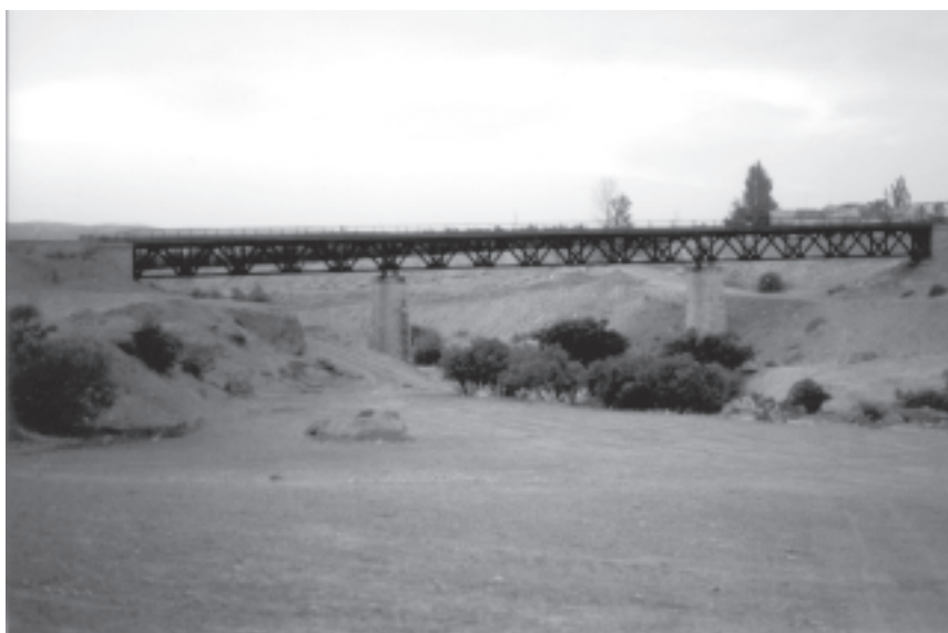
Fig. 6. Puente sobre el río Jandulilla.
