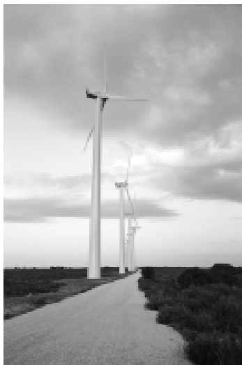
Aerogeneradores tripala, con rotor a barlovento y eje horizontal.
