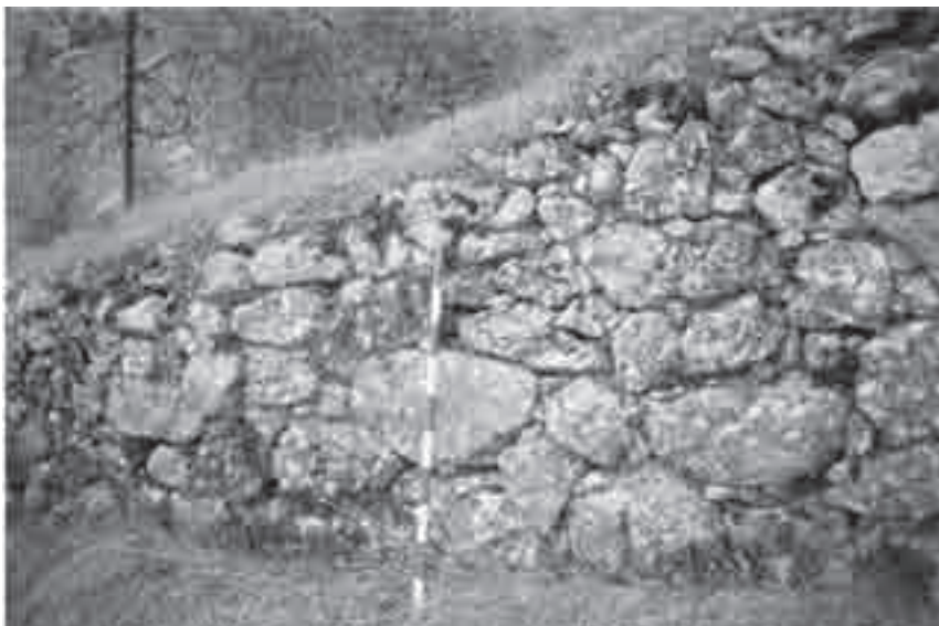
Nº 2. Detalle del muro A-1. Puerto de Abajo de Miguel Amando.
