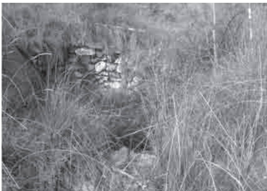
Nº 6. Vista de A-4. Muro de contención y canal de Alberca. Puerto de Abajo de Miguel Amando.
