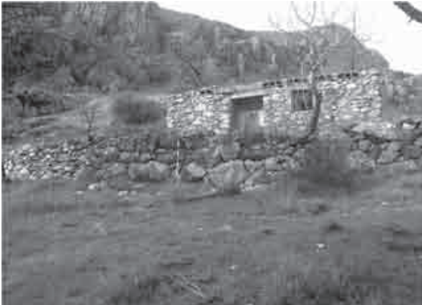
Nº 4. Vista de A-3. Cortijo, patín y muro de contención. Puerto de Abajo de Miguel Amando.
