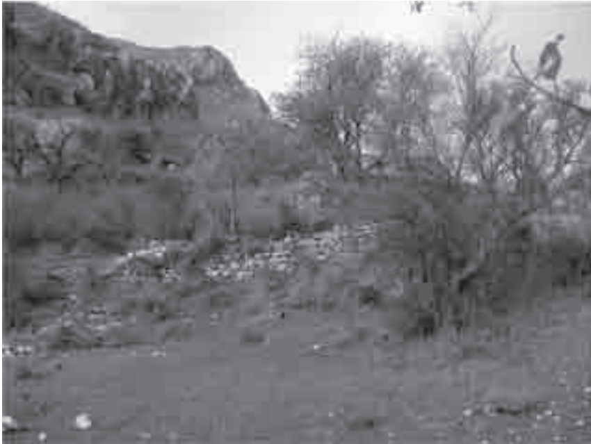
Nº 3. Vista del muro A-2. Puerto de Abajo de Miguel Amando.
