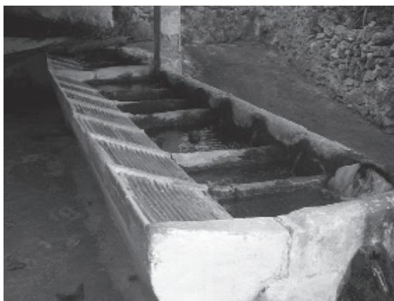
Vista de los lavaderos de la calle Molino antes de su rehabilitación
