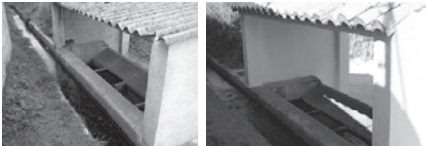
Lavaderos de la Ventilla sin rehabilitar y tras su rehabilitación.
