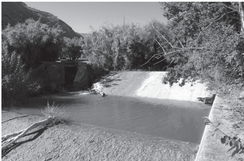
Presa actual del Molino Nuevo.
