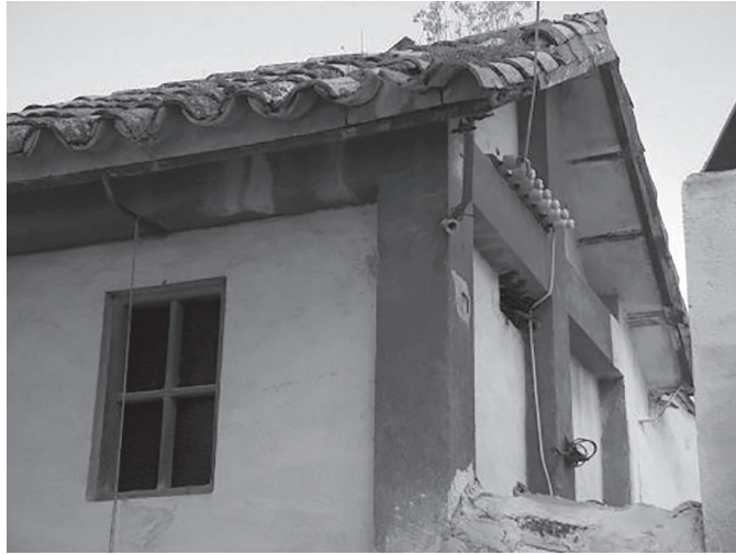
Primer centro de transformación y control en Alhambra
