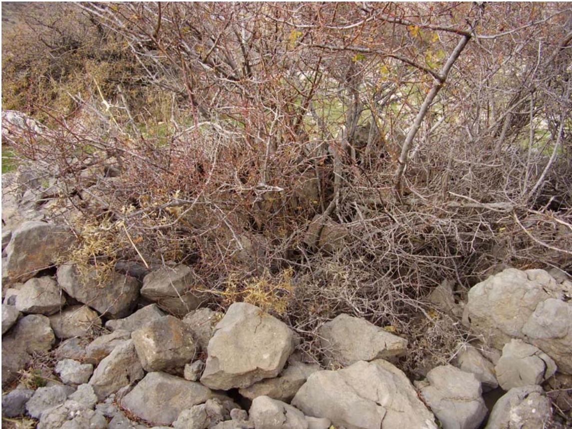
Fotos 1. Vistas del estado actual de la choza.
