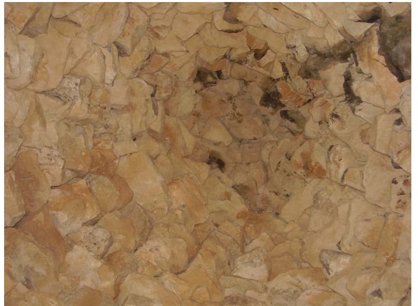
Foto 3. Detalle de la cúpula.
