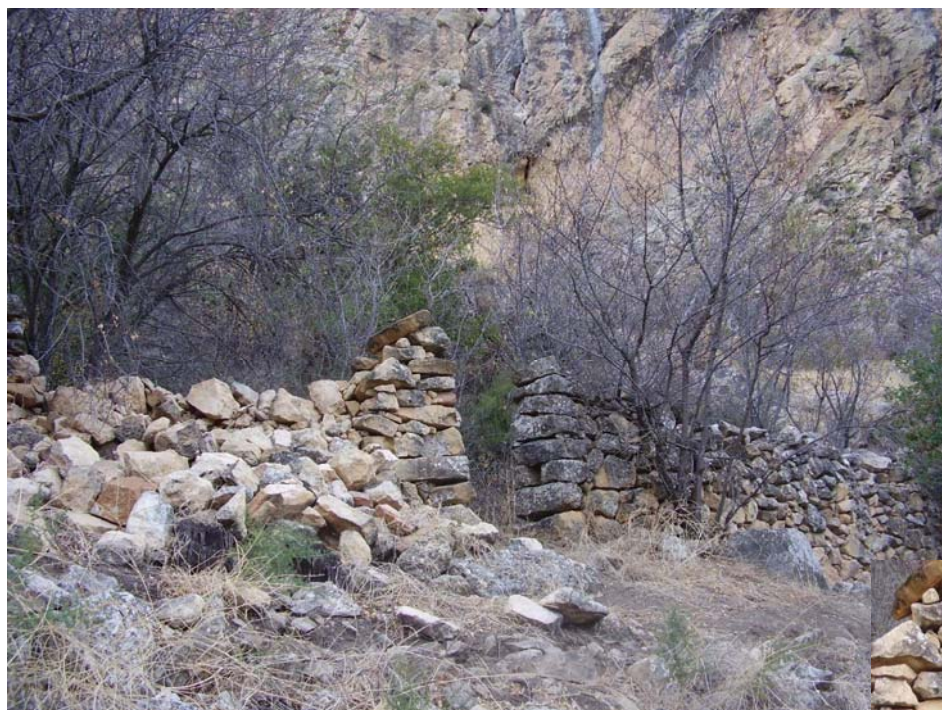
Foto 1: Vista de frente del "Corral de la Morra del Torcal"
