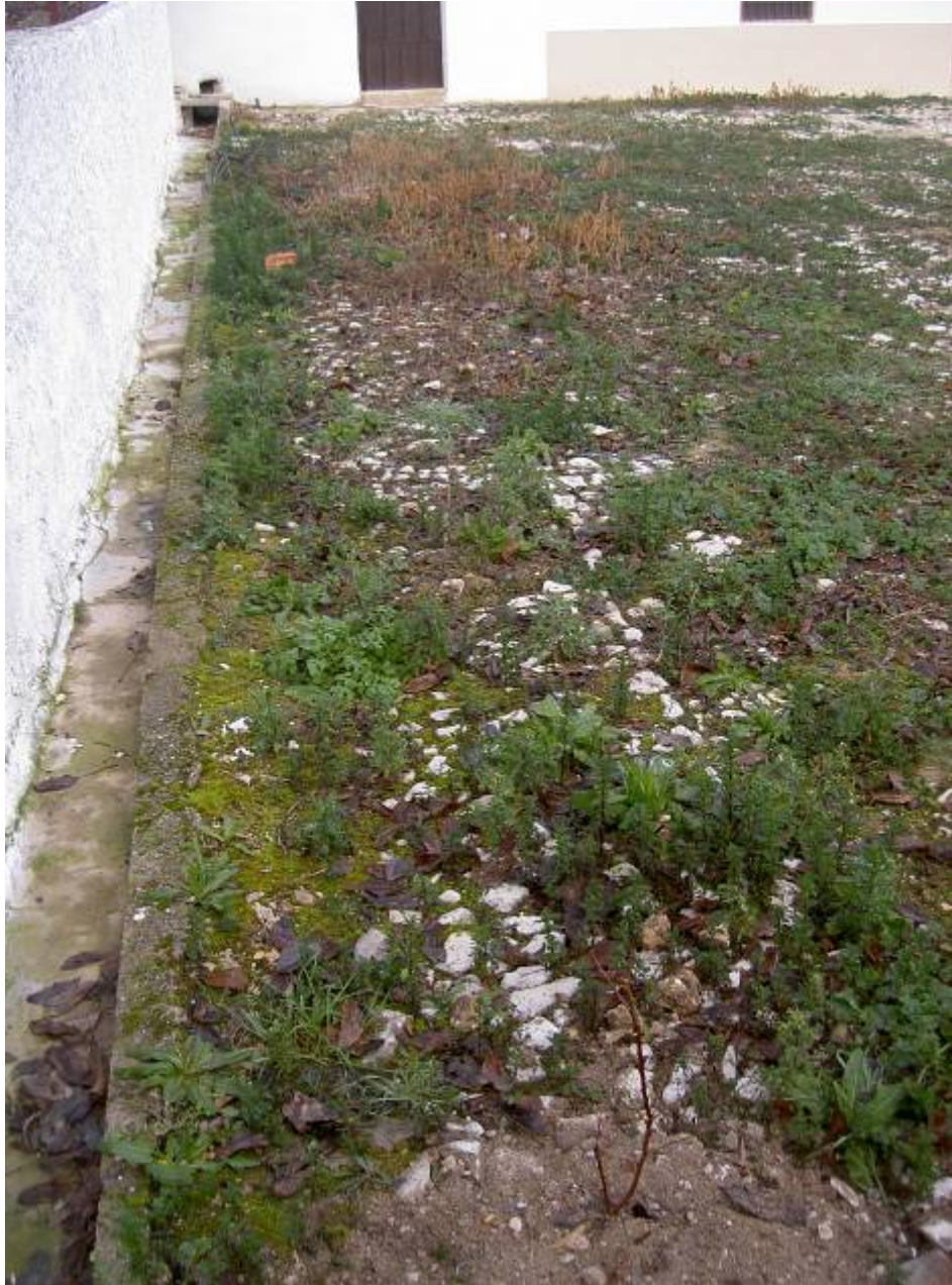
Detalle del canalizo de evacuación de aguas.
