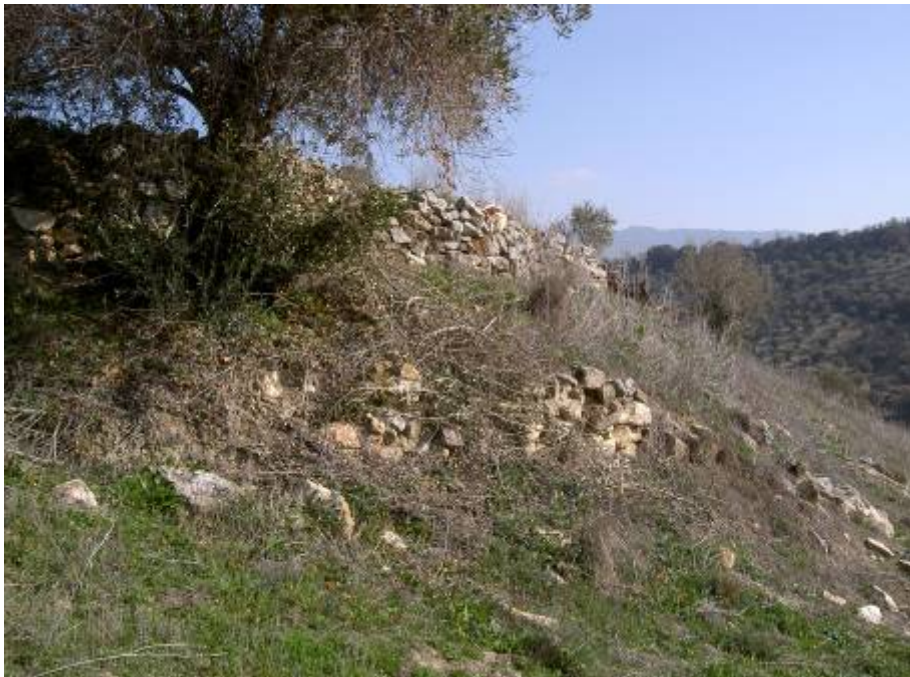
Detalle del muro de sujección de la era de Peraba
