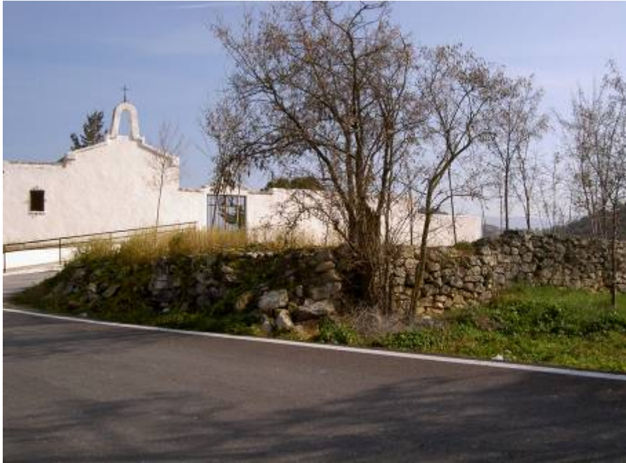
Muro oeste de sujección de la era. El Cementerio al fondo
