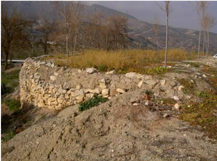
Muro de sujección de la parte oeste
