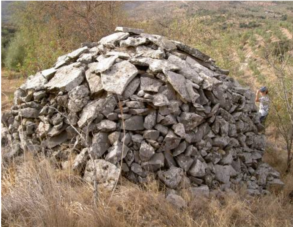
Detalle de la cubierta
