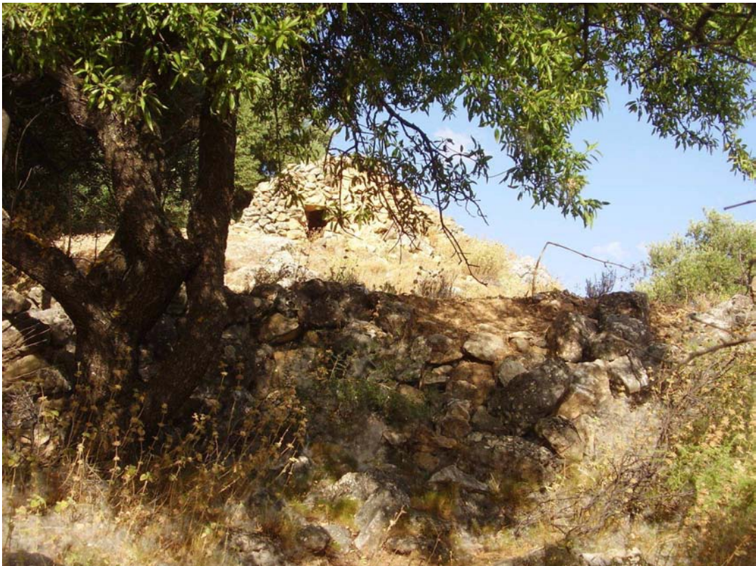
Vista parcial del corral del chozo-1 del Hoyo del Portillo
