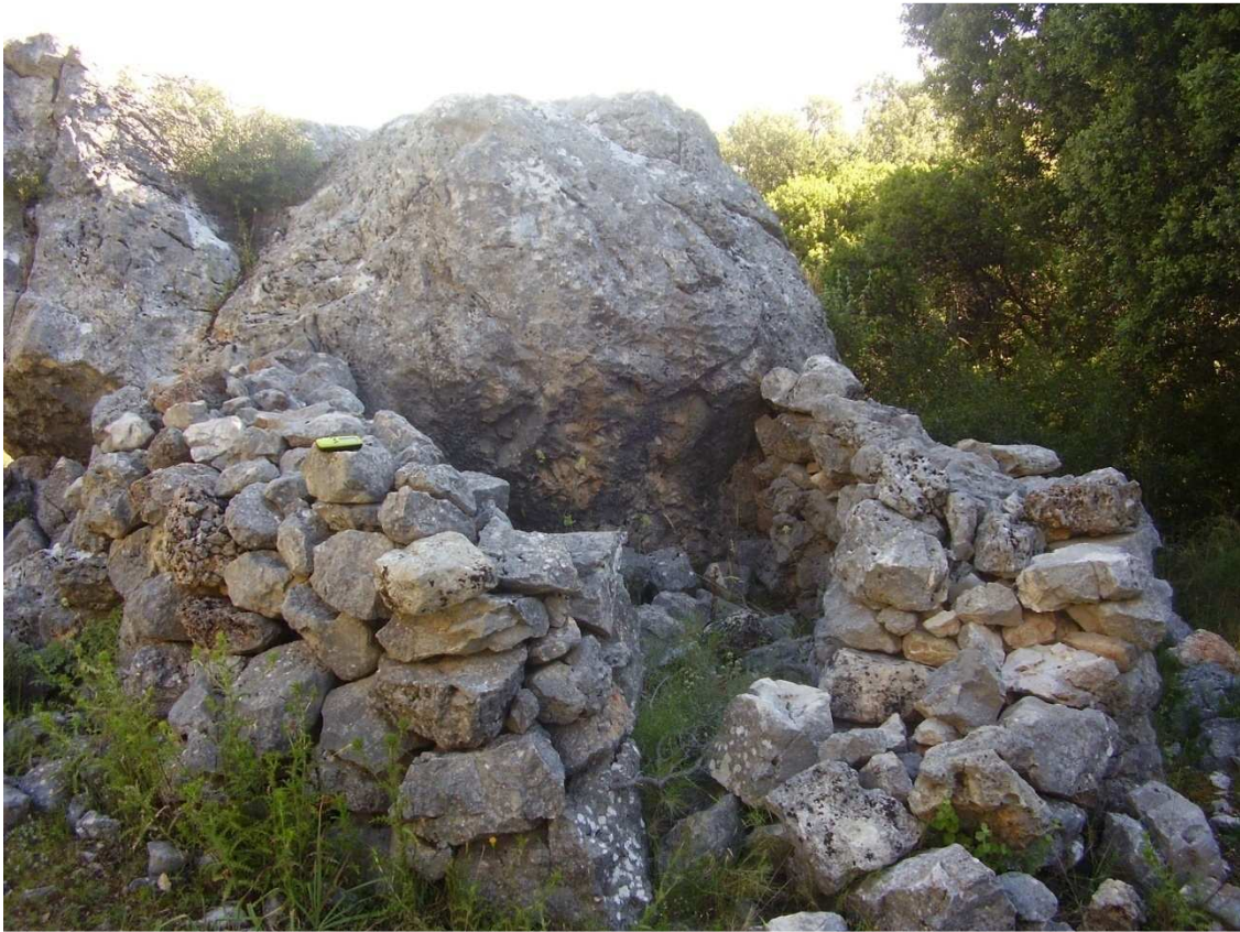
Vista del rancho del Hoyo del Peñón de Caballero
