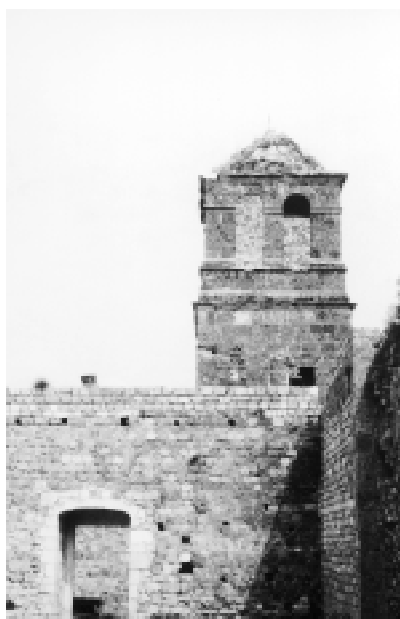
La Guardia de Jaén. Castillo. Torre de campanas de la iglesia de Santa María y lienzo de muralla con puerta.
