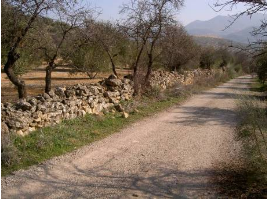
Detalle del muro del Lanchar de los Cierzos
