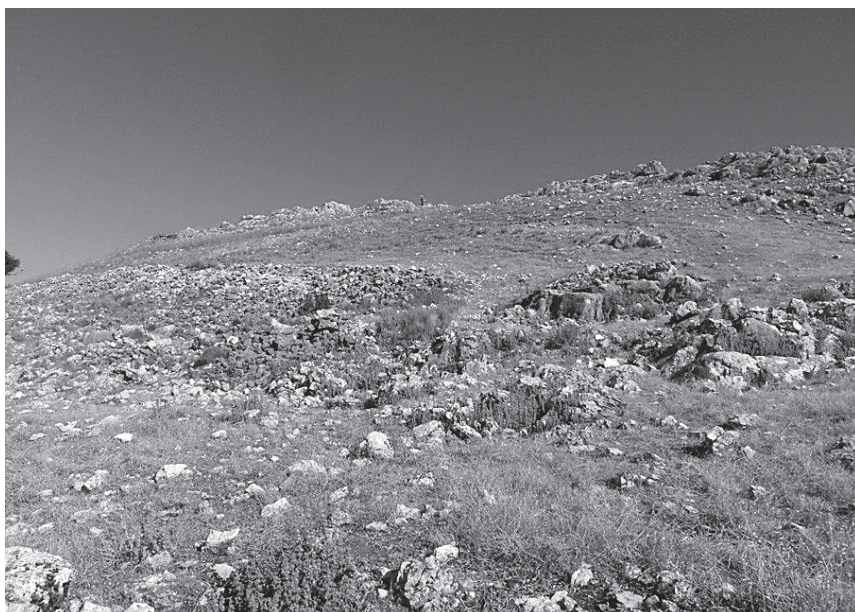
Muro del recinto interior del castillo de Cerrillo Tesoro
