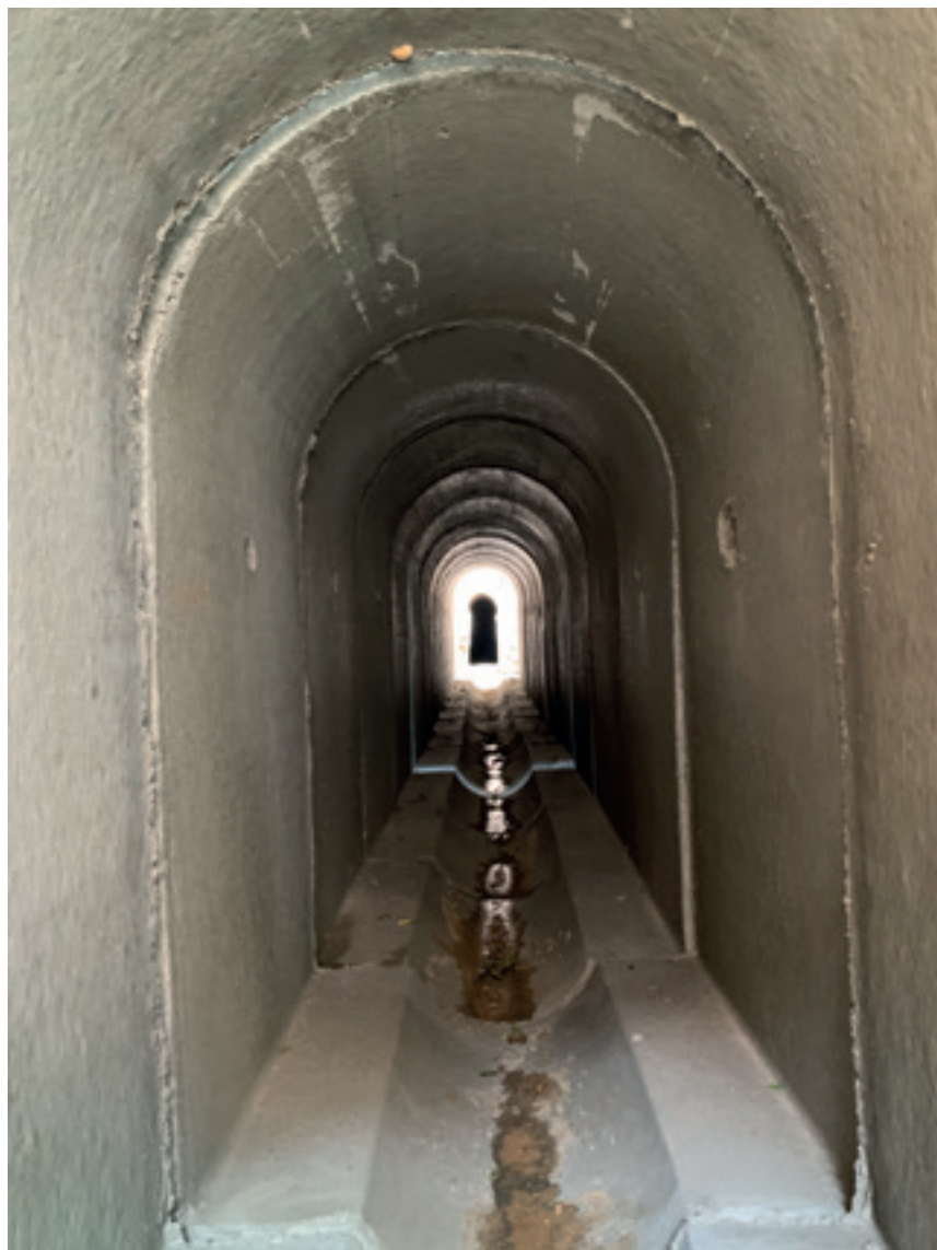
Interior de la nueva galería. Al fondo la continuación del viejo minado.
