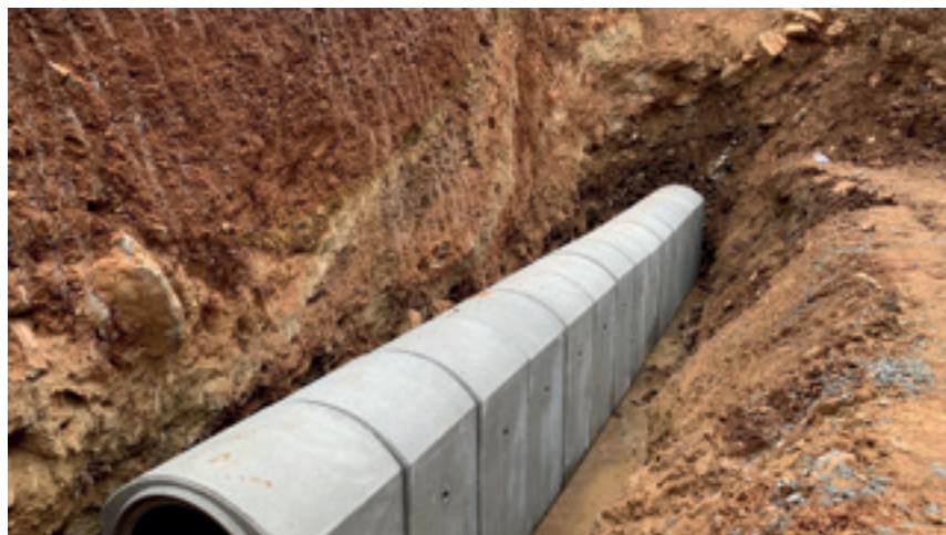
Formación de la nueva bóveda.
