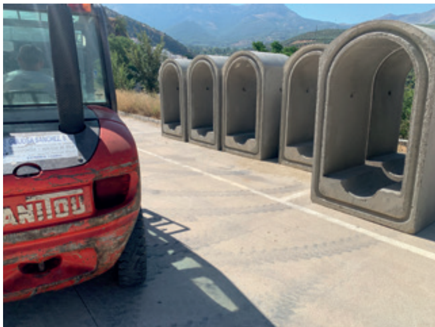
Recepción de los modelos prefabricados de hormigón armado para conformar la nueva bóveda.
