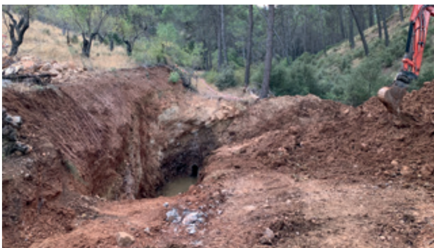
Inicio de las obras.
